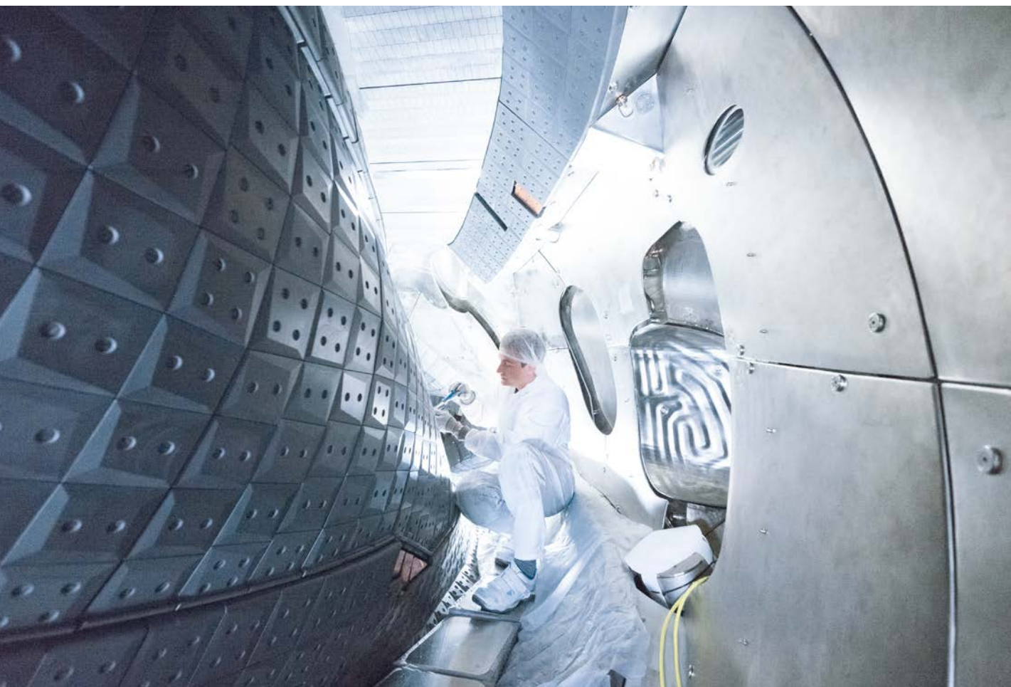
Montage der Graftkacheln im Plasmagefäß des sogenannten Stellarator-Experiments Wendelstein 7-X am Max-Planck-Institut für Plasmaphysik in Greifswald.
